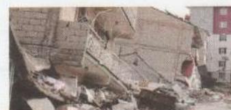
Colapso de viviendas
