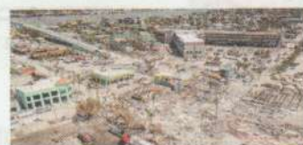
Destrucción de infraestructura
