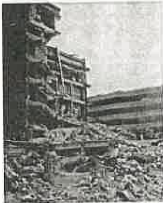
Afectaciones en la Ciudad de México por los sismos de 1985 y 2017
