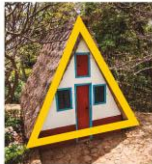
Techo de dos aguas
